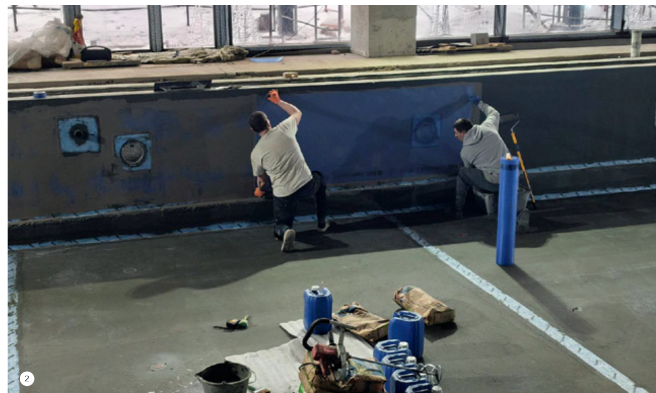
2-4. Материалы МАПЕИ применялись для выравнивания и гидроизоляции чаши бассейна, обходных дорожек и душевых.
